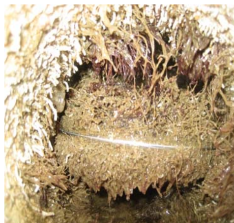
FILTRO SIN PTOTECCION
